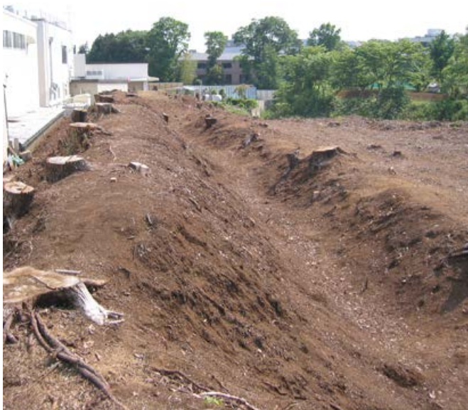
樹木を伐採したところ。土手(大)、堀、土手(小)が見える
