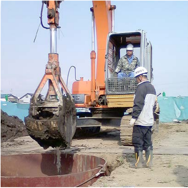
バケットで土をつかみ上げたところ (手前のさび色のものは土が崩れないように支える筒状の鉄板)
