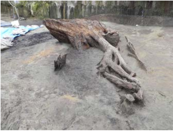
斜面に生えた木を利用した足場 (向かって左が谷側、右が山側)
