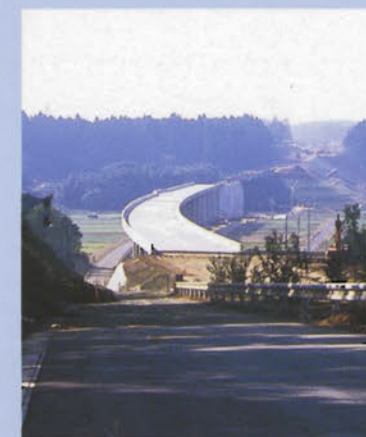
工事中の千葉東金道路
