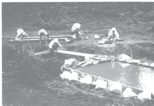
第4図 シューターを使用した水洗
