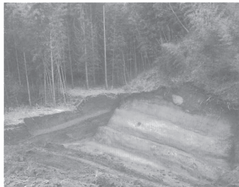
平場 2・3 完掘状況
