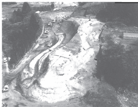
平場11・14完掘状況
