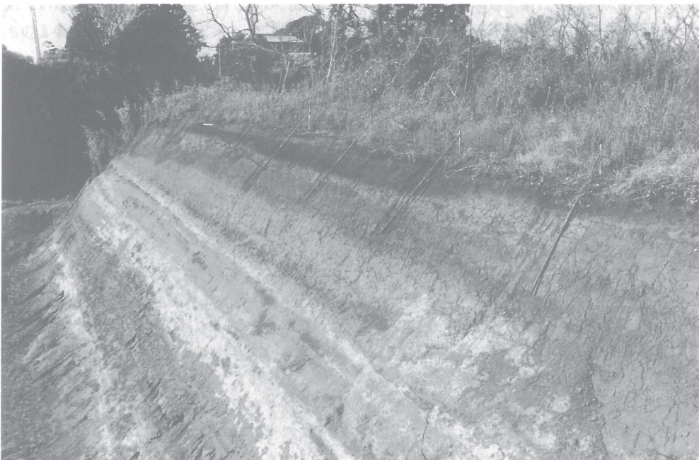
写真2 下新田-立野ルート袖ヶ浦市西萩原付近の遺構断面
