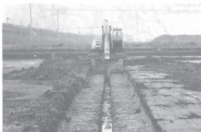
写真3 トレンチの側溝
