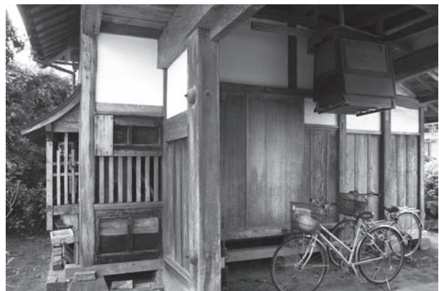
図版109 木戸陣屋移築長屋門
