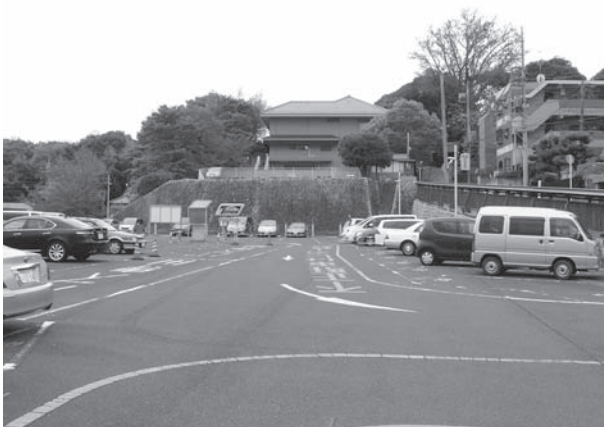
図版44 戸定陣屋跡遠景
