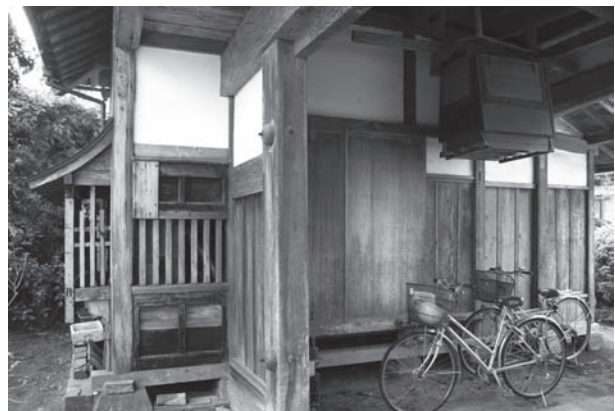
図版109 木戸陣屋移築長屋門
