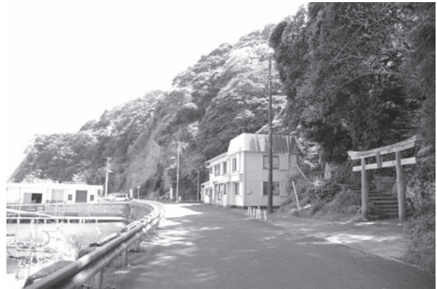
図版133 興津弁天岬台場跡付近遠景
